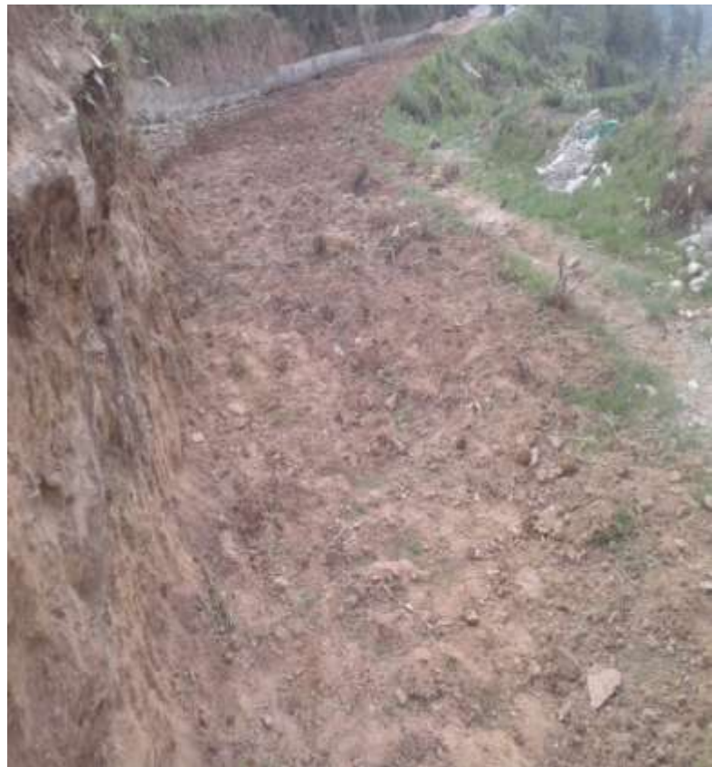
वडा खोला देखि भैरव मा.वि खोर अन्तर्गत खगेना बाटो मर्मत पछिको दृश्य ।
