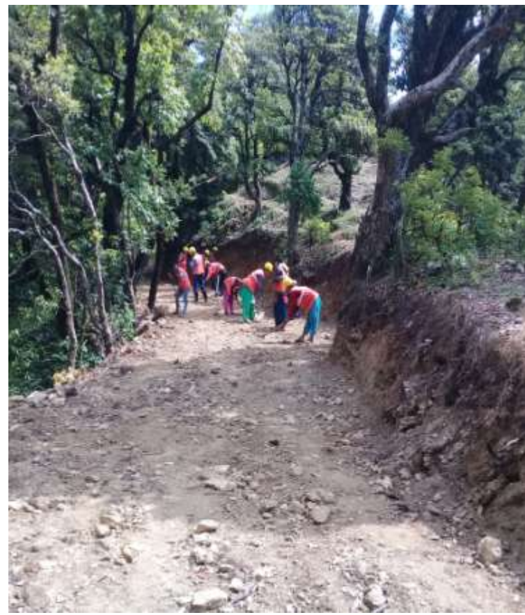
मालिका मन्दिर जाने बाटो निर्माण कार्य सम्पन्न पछिको फोटो ।
