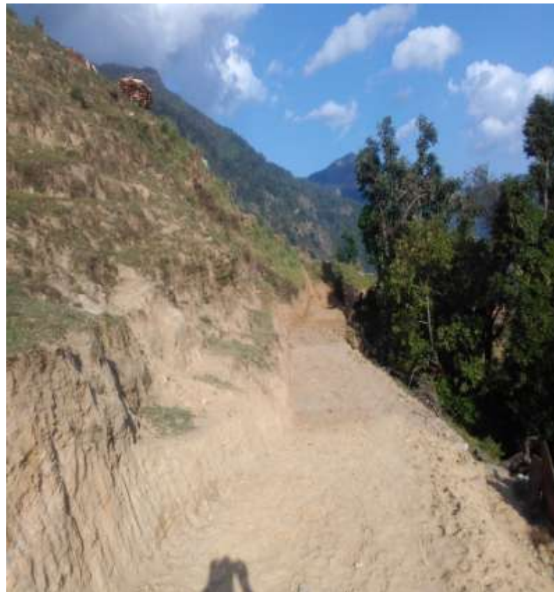
वडा नं. ३ मेहेलतोलि स्थित भर्सुली ठाटा सडक निर्माण कार्य पछिको दृश्य ।
