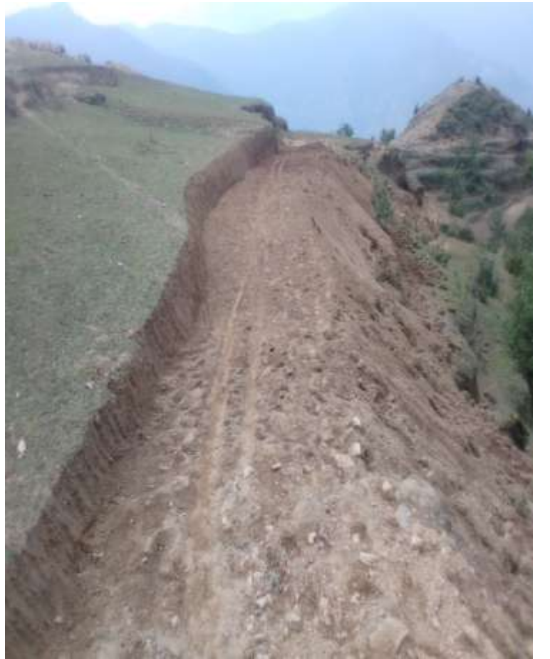
वडा नं. ३ मेहेलतोलि स्थित भर्सुली ठाटा सडक निर्माण कार्य पछिको दृश्य
