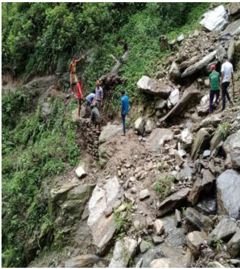
वडा नं. ५ गनसैन देखि सहडे सडक निर्माण हुनु अधीको दृश्य ।
