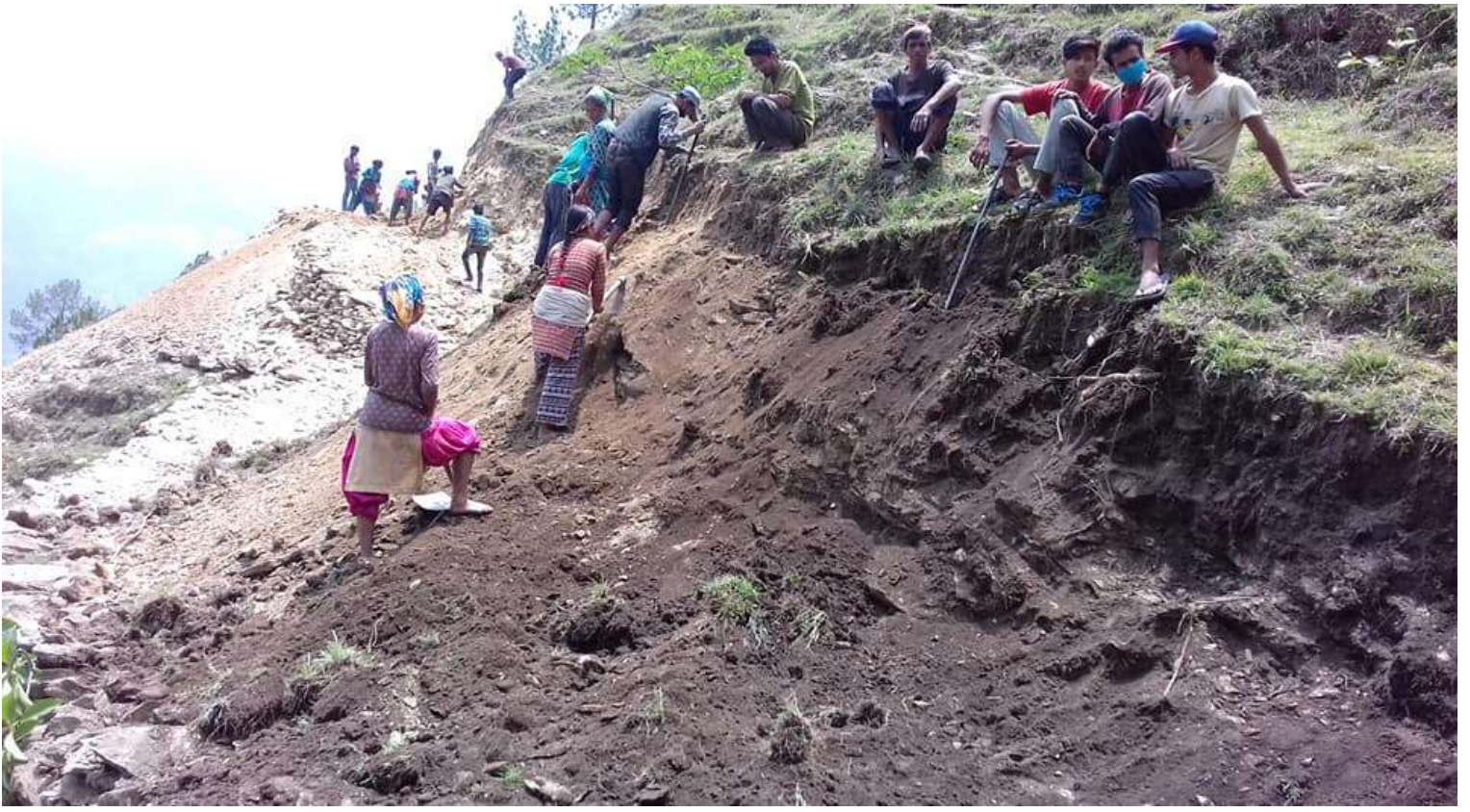
चित्र नं. ३ : वडा नं. १ चिसी खोल देखि दाल्का पानि बाटो निर्माण कार्यमा जटेका श्रमीक टोलिको दृश्य ।
